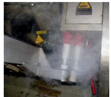
Bild 19: Zwischendesinfektion muss Systemunabhängig laufend kontrolliert werden. LK Stmk
