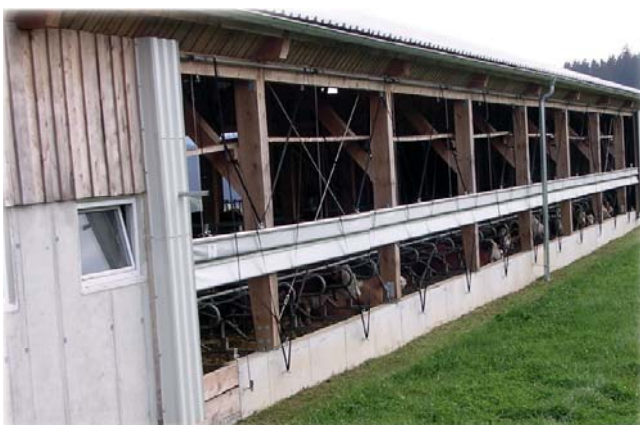
Geöffnete Wand mit Curtain.
