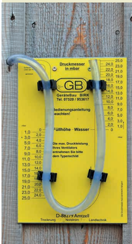
Drucküberwachung mittels U-Schlauch
