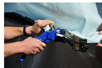
Verschweissen der Ecken mit der Schweißzange.
