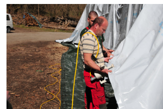
Verschweissen der Folie mit dem Schweißgerät.
